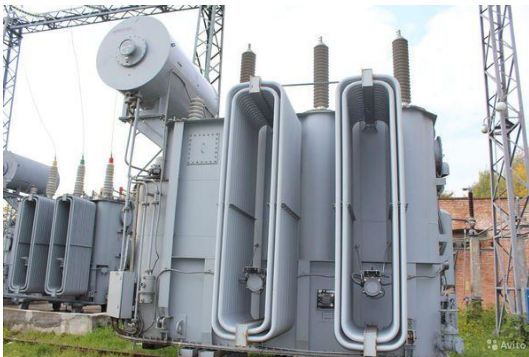
Рисунок 2 – Трансформатор ТРДН-25000/110
