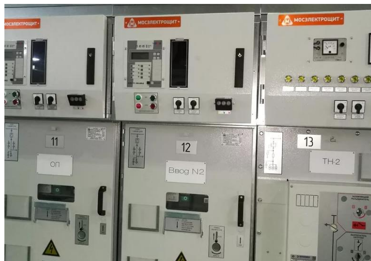
Рисунок 13 – Ячейки КРУ
