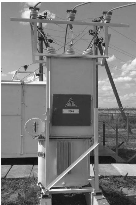
Рисунок 2 – Ячейка ТСН на понижающей подстанции ПС-35/10 кВ «Лапени» Могилёвских электрических сетей
