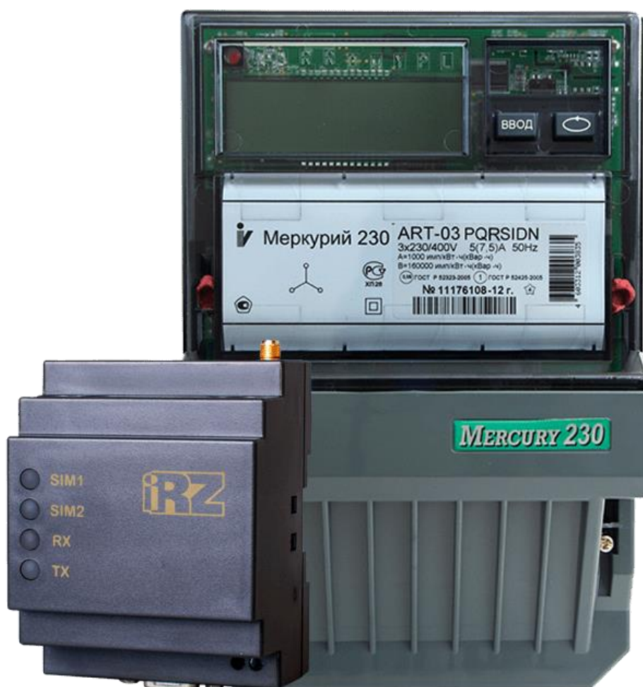
Рисунок 4 – Конструктивное выполнение и функционал счётчика «Меркурий 230 ART»
