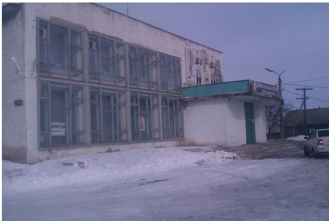
Рисунок 1 - Вид с улицы 3- го Октября. Центральный вход (южная сторона)
