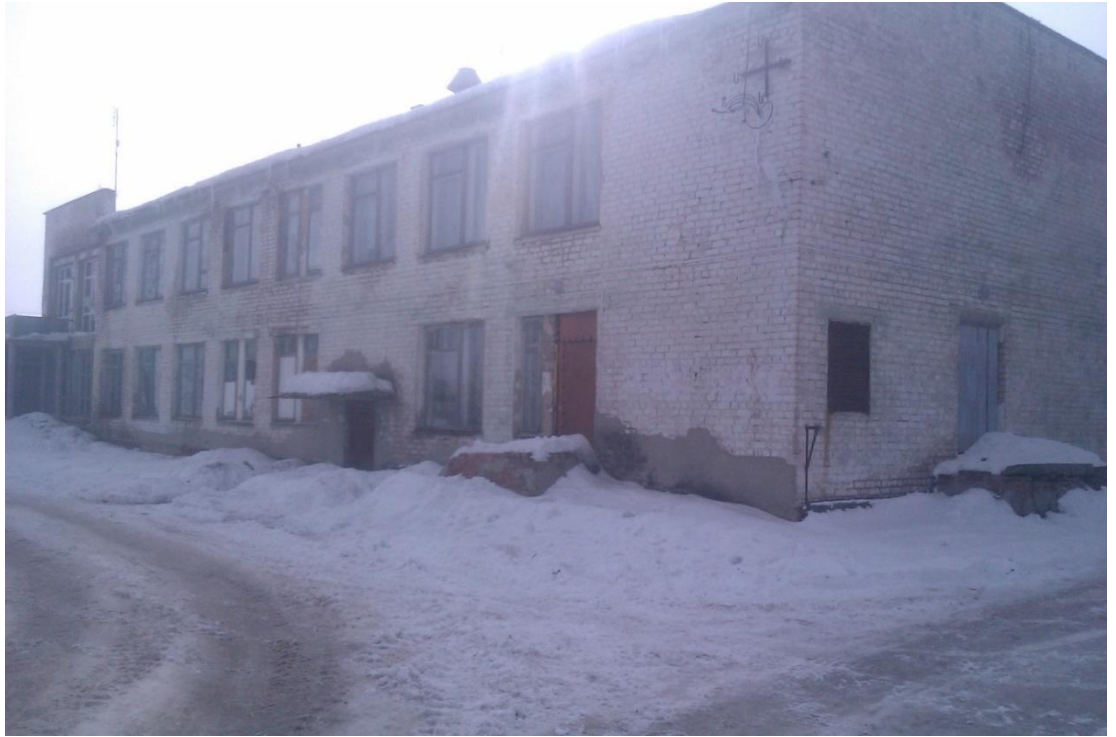
Рисунок 4 - Вид с улицы Пионерская (Восточная сторона)
