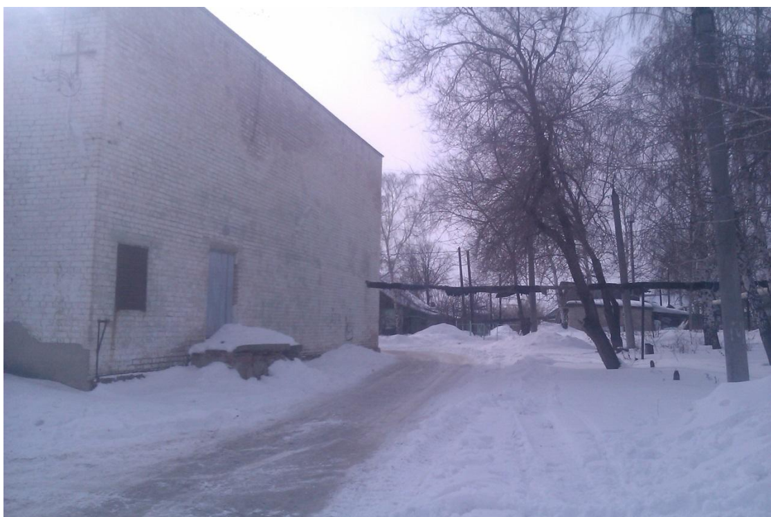
Рисунок 3 - Вид с улицы Плодовая (Северная сторона)
