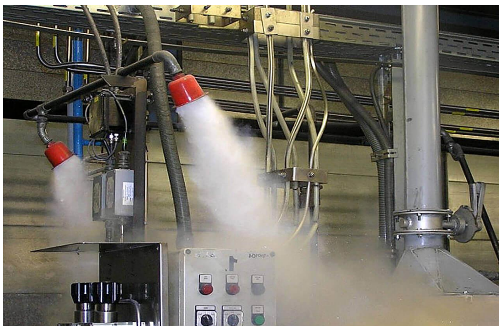
Рисунок 5 – Системы порошкового и аэрозольного пожаротушения
