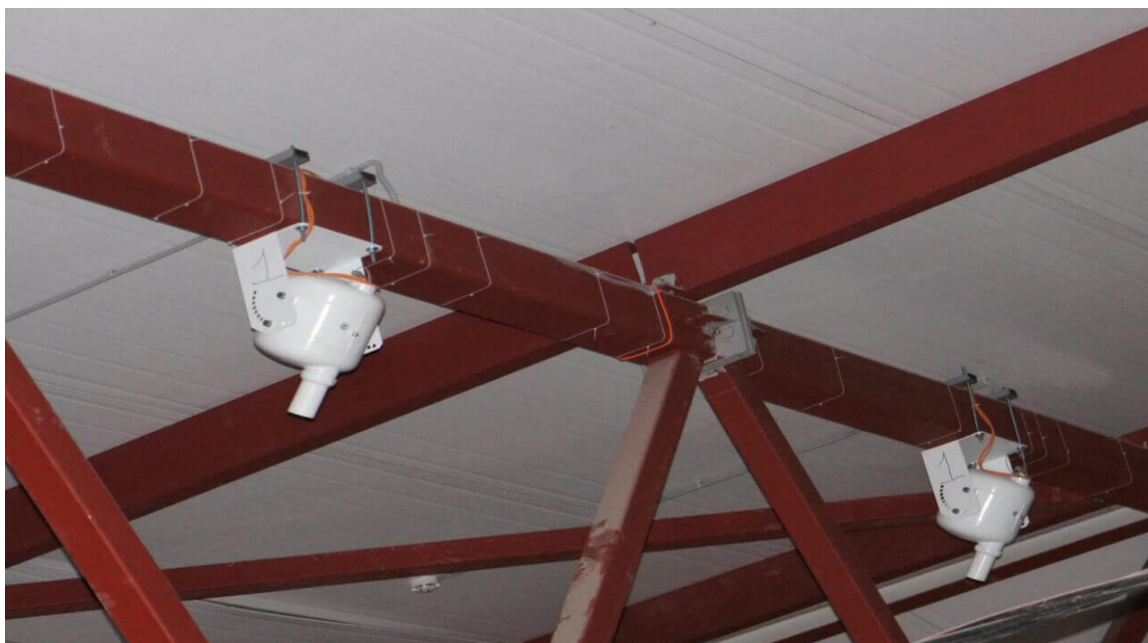
Рисунок 4 – Системы порошкового и аэрозольного пожаротушения
