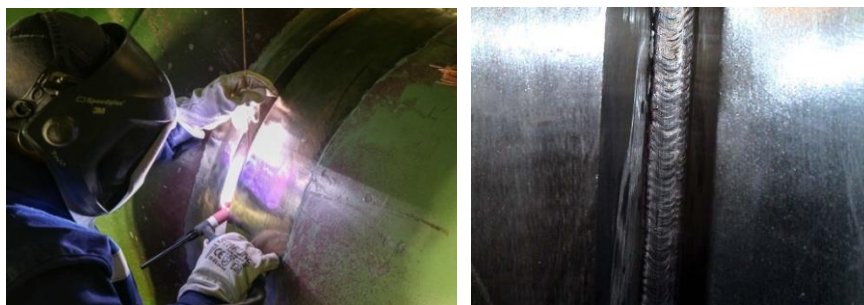
Рисунок 9 – Корневой слой шва
