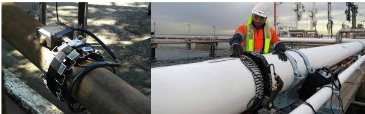
Рисунок 14 – Проведение контроля состояния магистрального трубопровода с применением методики низкочастотной ультразвуковой диагностики
