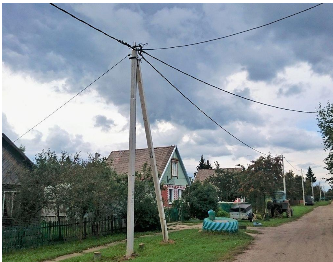
Рисунок 7 - Самонесущий изолированный провод на железобетонной анкерной опоре, ЛЭП 0,4 кВ
