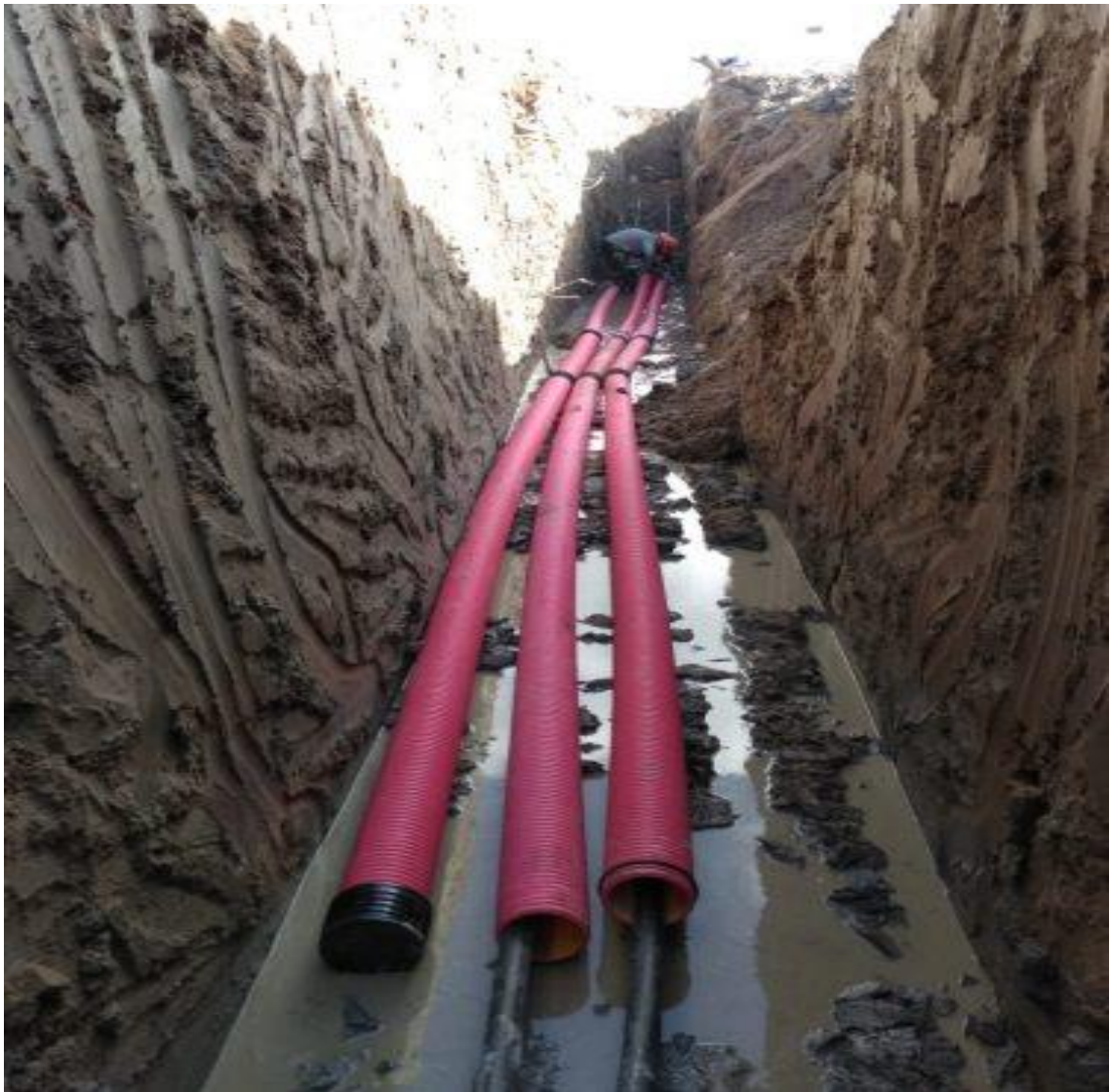
Рисунок 5 – Прокладка кабельной линии 10 кВ
