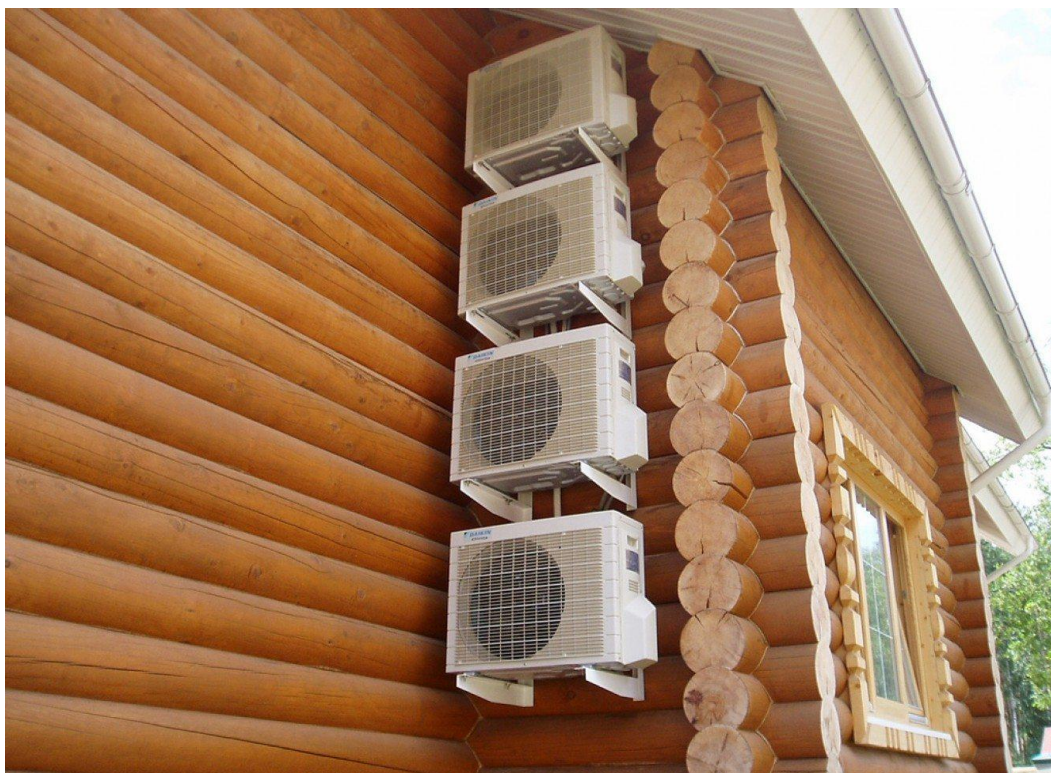
Рисунок 8 – Система кондиционирования в частном доме
