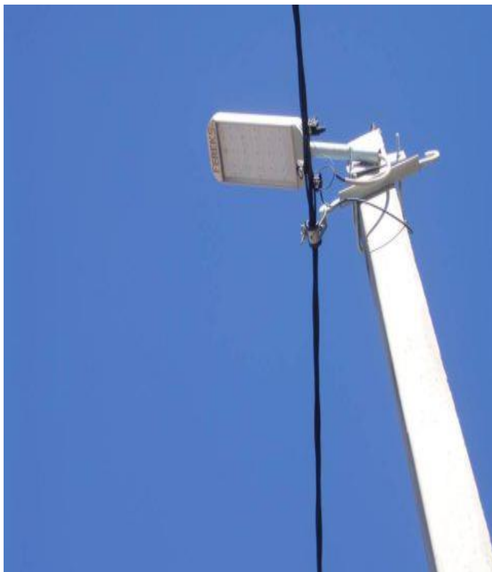
Рисунок 10 – Светодиодный светильник на железобетонной опоре
