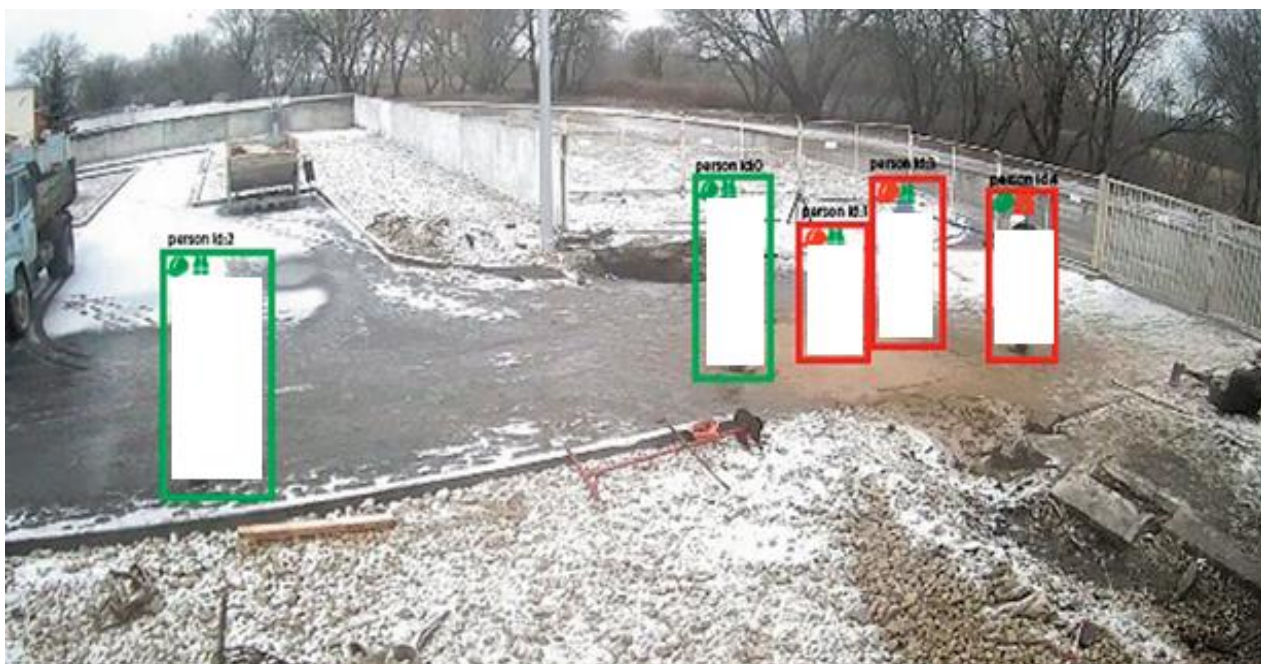
Рисунок 1 – Пример работы модуля SMARTEC (бренд компании «АРМО-Системы») обнаружения людей и контроля использования СИЗ
