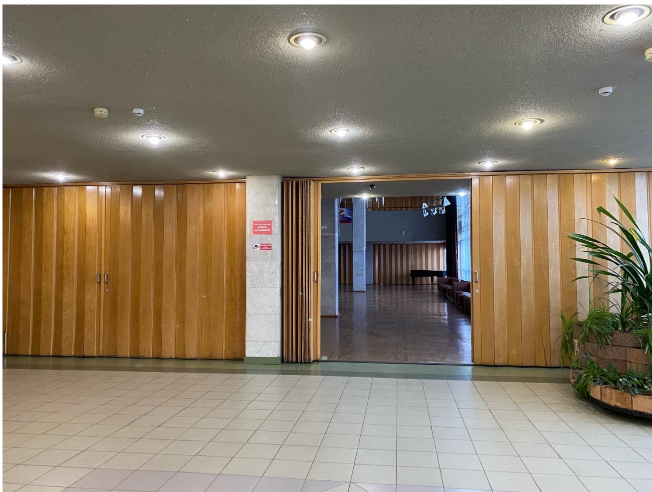
Рисунок Б.2 – «Двери-гармошки», установленные в «Культурном центре «Автоград»
