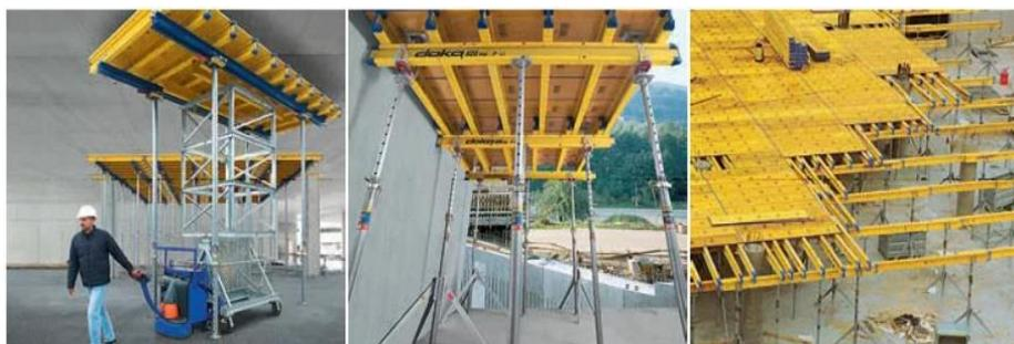
Рисунок 14 – Монтаж опалубки
