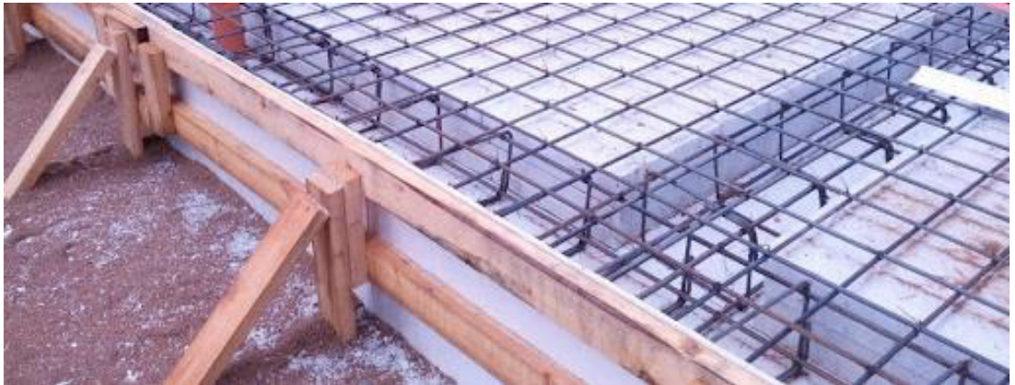
Рисунок В.2 – Схема устройства опалубочных конструкций под фундаментную плиту возводимого здания ДПЦ
