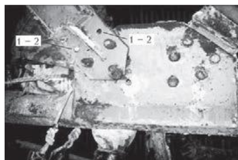
Рисунок 2 – Погнутость элементов горизонтальной связи (а) и смещение элементов в узловой фасонке (б)
