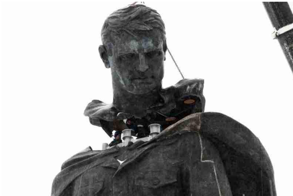
Рисунок 5 – Процесс установки головы фигуры воина-солдата
