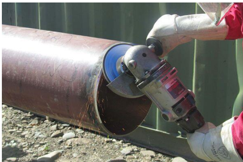
Рисунок 6 – Подготовка кромок трубопровода к сварке
