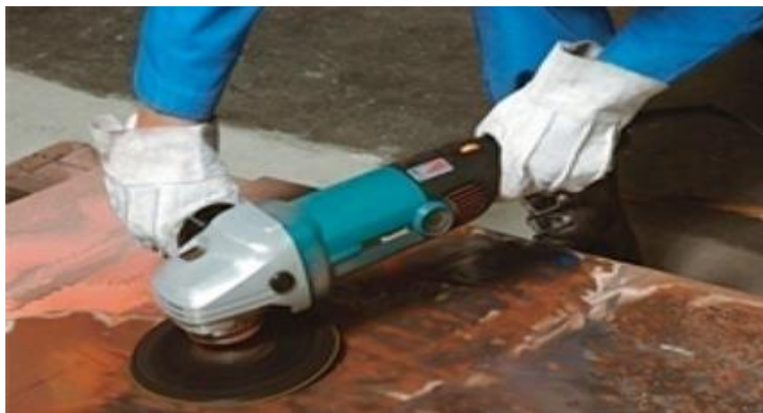
Рисунок 10 – Очистка поверхности ковша экскаватора
