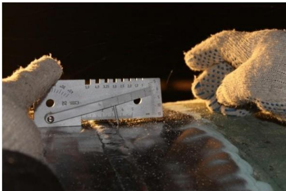
Рисунок 14 – Контроль качества сварных соединений
