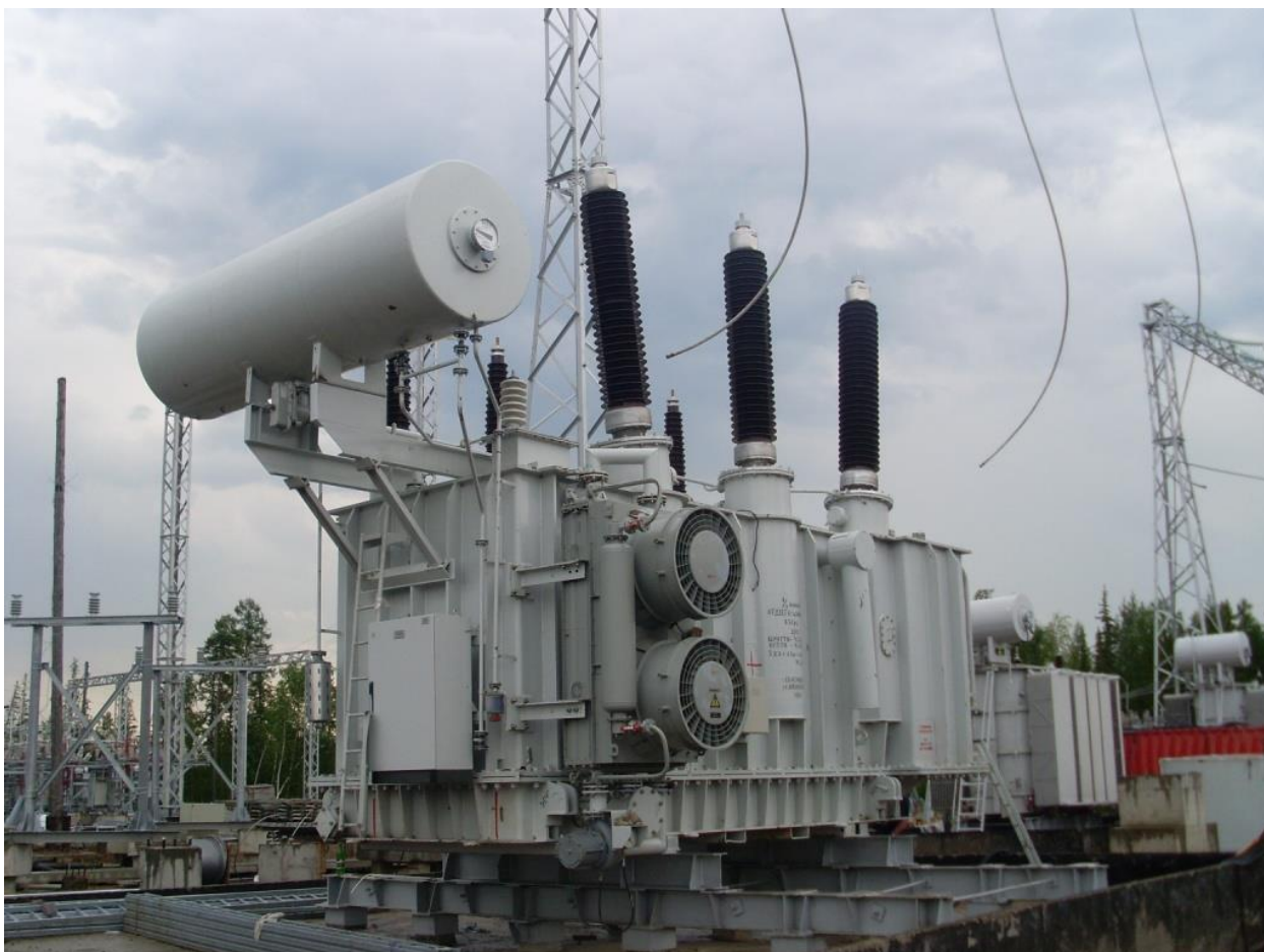
Рисунок 5 – Трансформатор АТДЦТН-63000/220/110-У1
