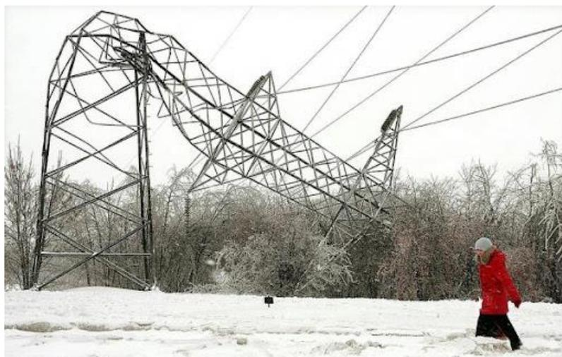
Рисунок 11 – Повреждение опоры вследствие образования наледи
