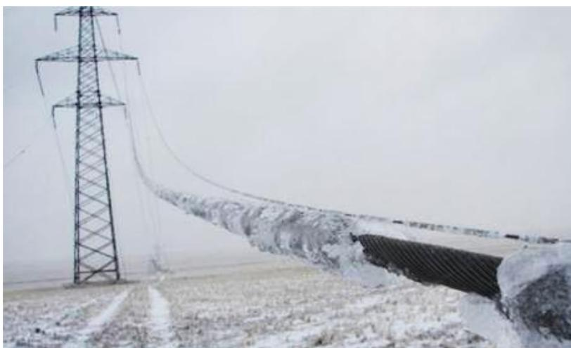
Рисунок 10 – Провис провода из-за льда
