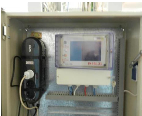
Рисунок 18 – Шкаф УСПД
