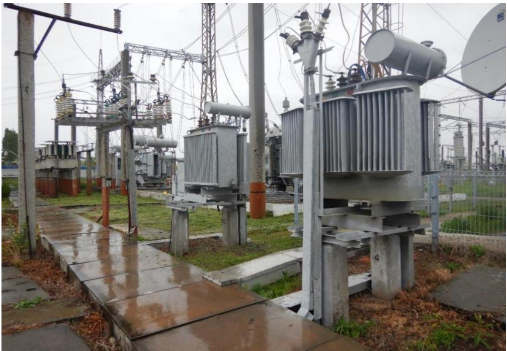
Рисунок 3 – Внешний вид ТСН-1 и ТСН-2
