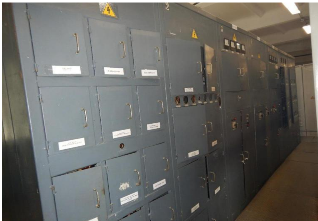
Рисунок 4 – ЩСН 0,4 кВ в ГЩУ
