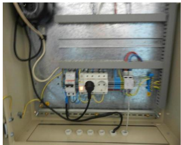
Рисунок 18 – Шкаф УСПД
