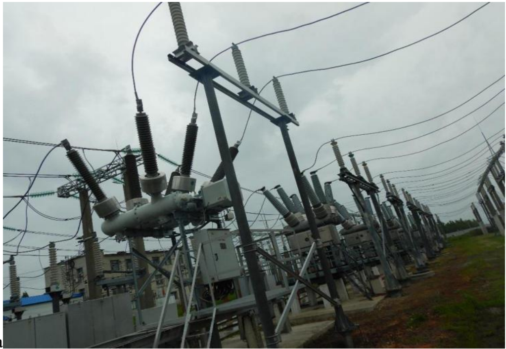
Рисунок 2 – Внешний вид рядов выключателей 110 кВ и шинных опор 110 кВ
