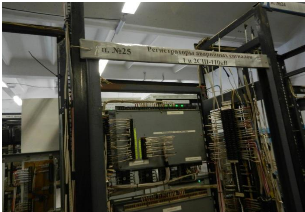
Рисунок 7 – Существующие устройства РАС
