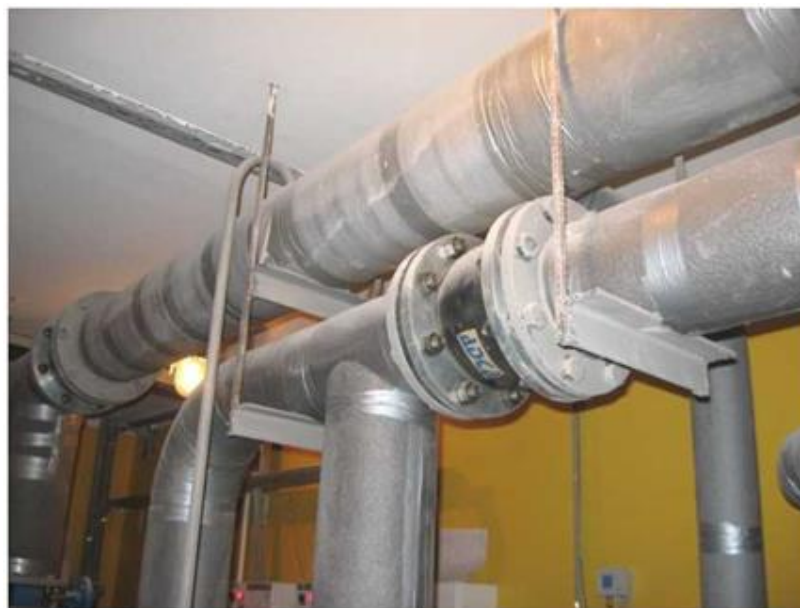
Рисунок 9 – Подвесы Трубы до мероприятий по снижению вибрации
