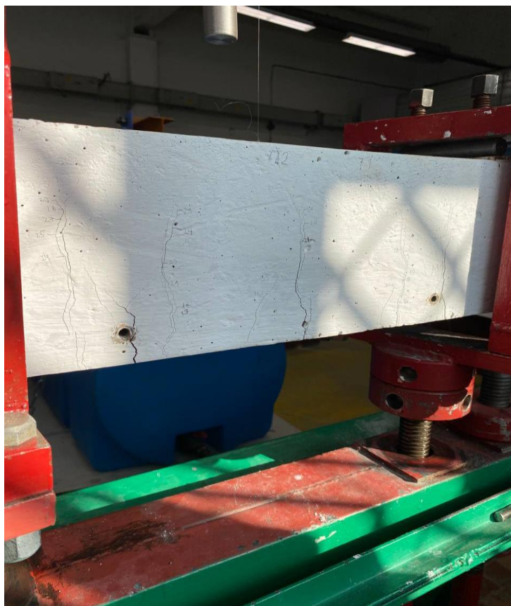
Рисунок 26 – Трещины в середине пролета балки сплошного сечения
