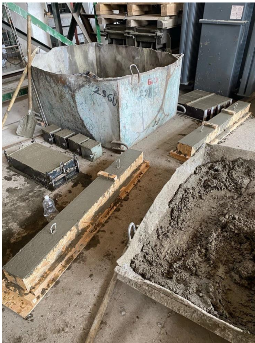
Рисунок 14 – Образцы балок после бетонирования
