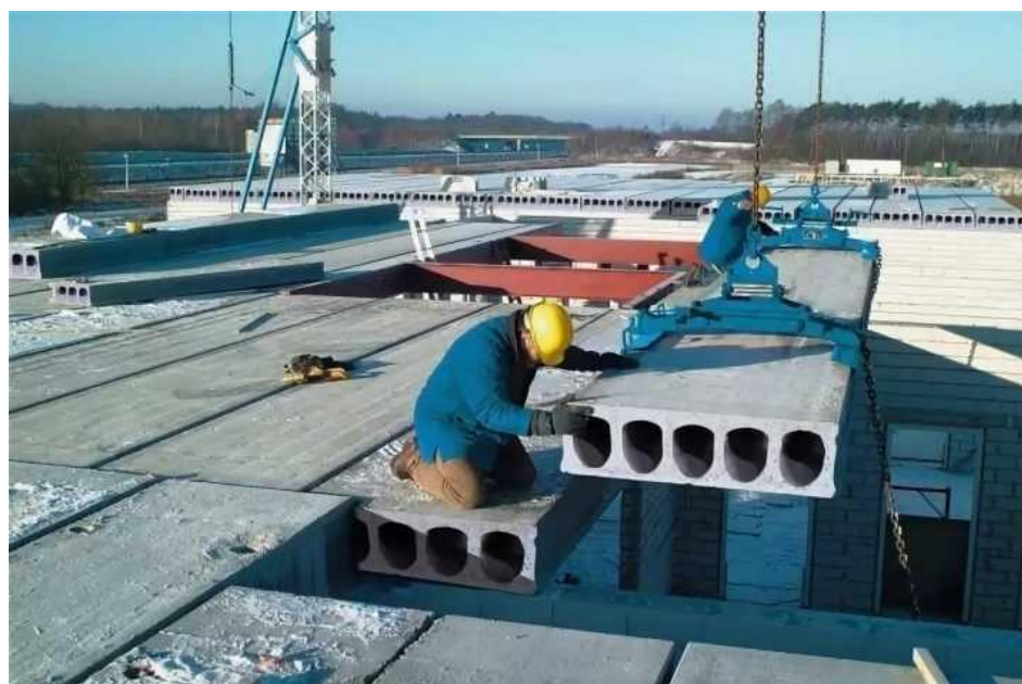
Рисунок 4 – Многопустотная железобетонная сборная плита марки ПБ во время монтажа
