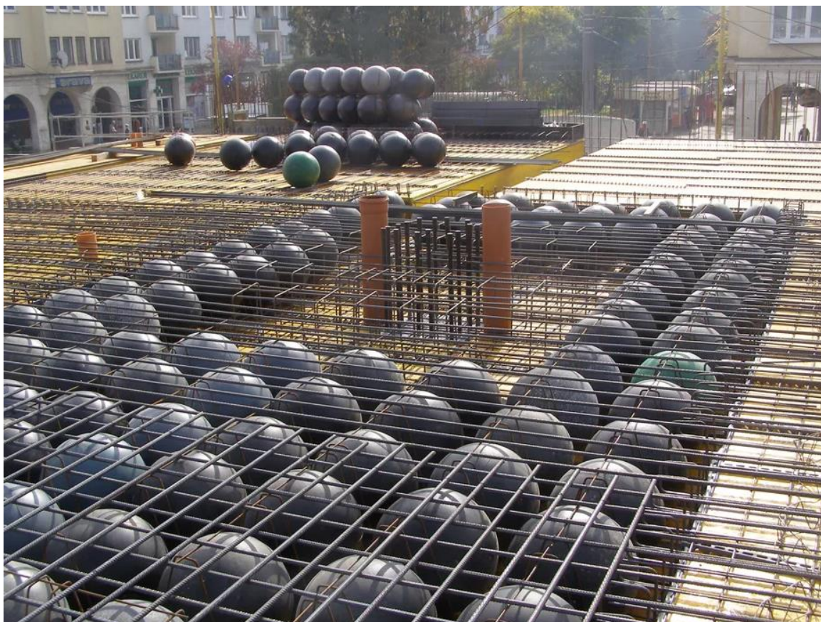
Рисунок 8 – Процесс укладки шаров перекрытия «BubbleDeck»
