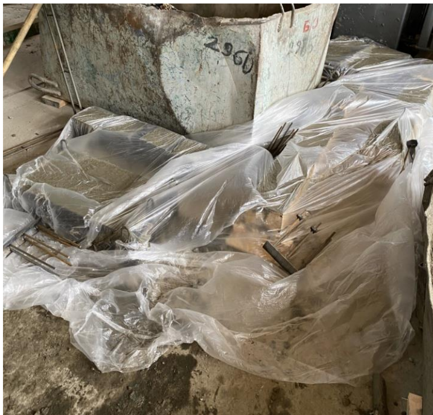
Рисунок 11 – Защита забетонированных конструкций
