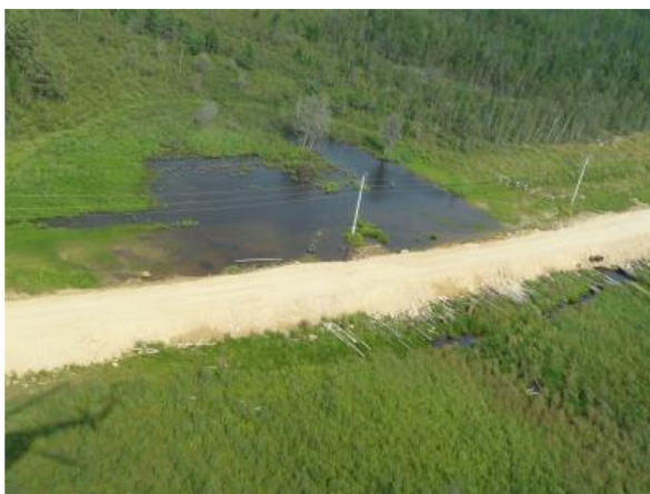
Рисунок 2 – Внешний вид термокарста с просевшим участком трубопровода
