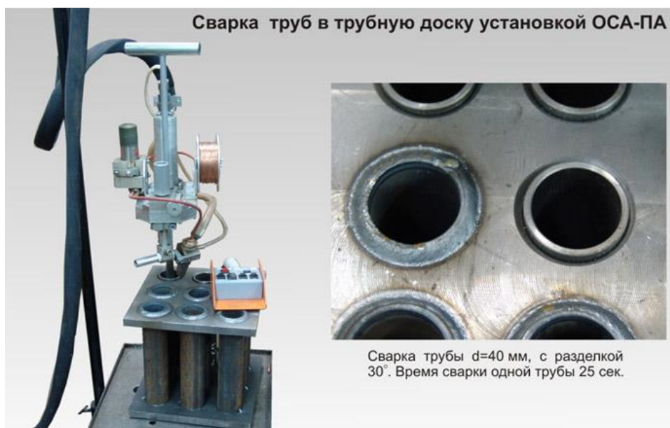
Рисунок 17 – Сварка труб с трубной доской с использованием установки ОСА-ПА
