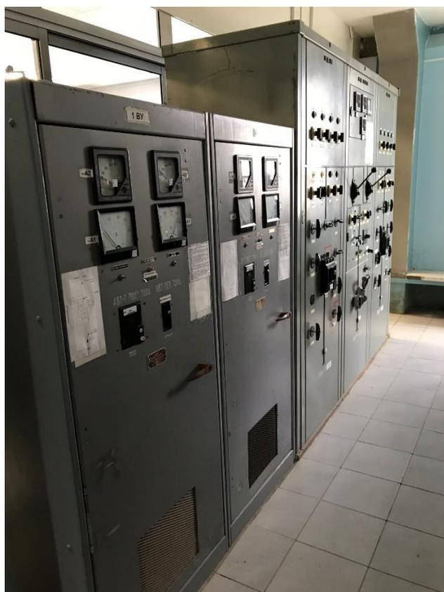
Рисунок 4 - Щит постоянного тока ЩПТ-1 и зарядно-выпрямительные устройства
