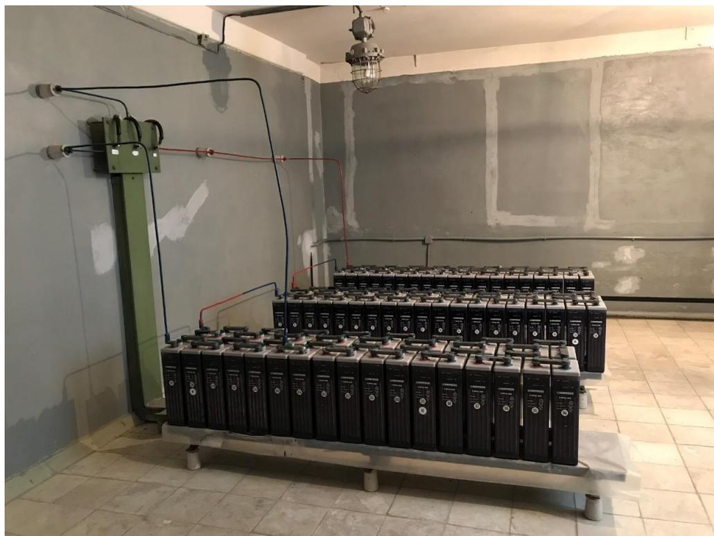
Рисунок 3 - Аккумуляторная батарея АБ-2
