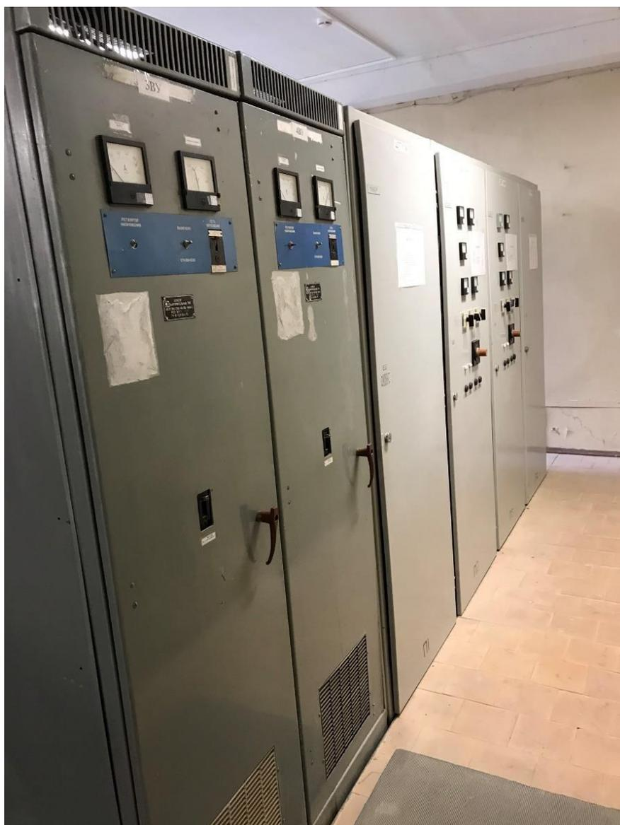
Рисунок 6 - Щит постоянного тока ЩПТ-2 и зарядно-выпрямительные устройства
