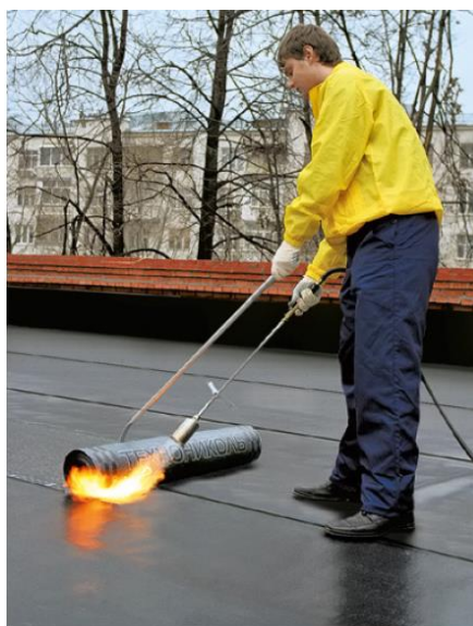
Рисунок 5 – Положение рабочего при укладке
