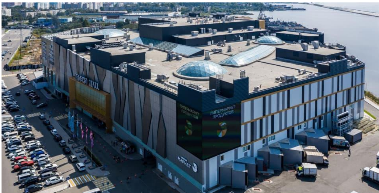
Рисунок 2 – ТРЦ «БРОСКО МОЛЛ» вид с северной стороны
