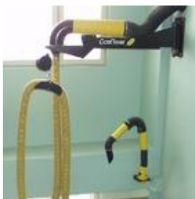
Рисунок 4.3 - Консольно-поворотное вытяжное устройство VEGA
