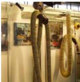
Рисунок 4.2 - Компактное вытяжное устройство DROPPER компактное вытяжное устройство, эконом-вариант, крепление к стене / балке
