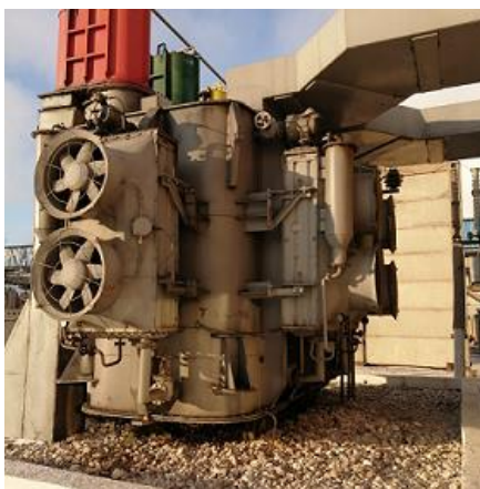
Рисунок 2 - ТРДЦНК 63000 110/6 с регулированием напряжения под нагрузкой по стороне 110 кВ на ГПП-60
