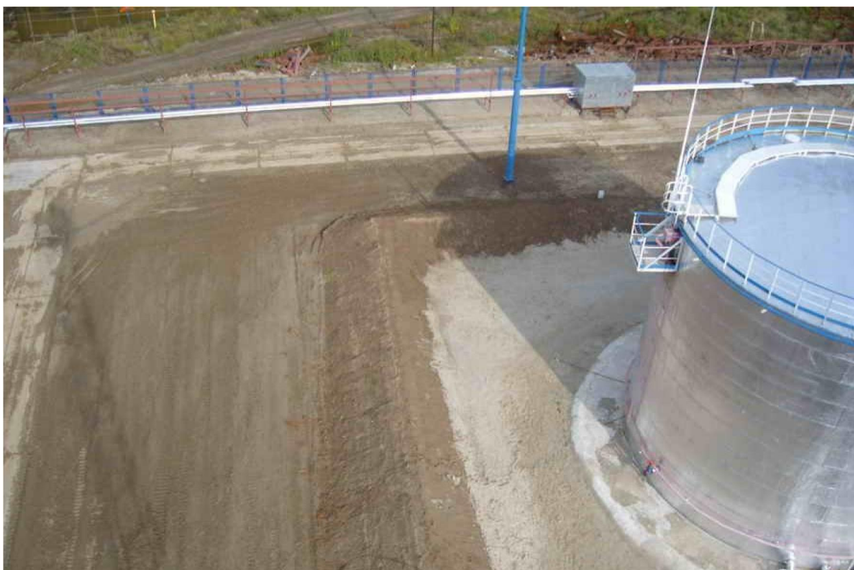
Рисунок 2 – Пример выполнения земляного обвалование на объекте
