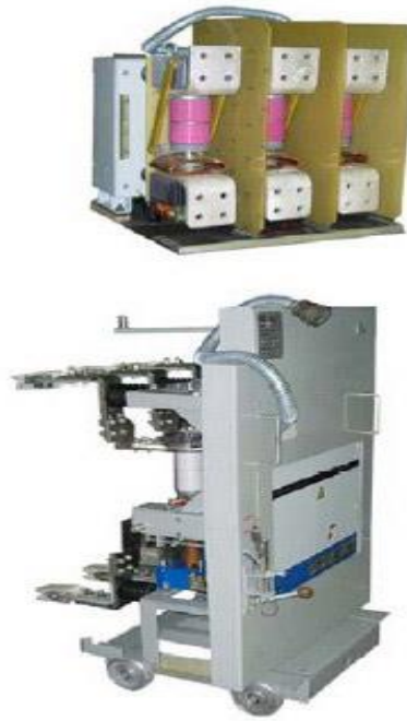
Рисунок 5 – Общий вид выключателя ВБМ-10
