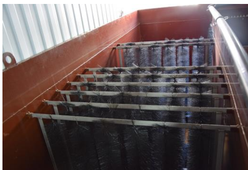
Рисунок 5 – ОС оборудованные ершовой загрузкой в условиях действующего производства ЛПДС «Башмаково»
