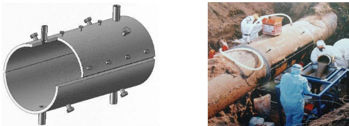
Рисунок 9 – Ремонтная муфта П1 для ремонта магистрального нефтепровода с заполнением композитным компанаудом
