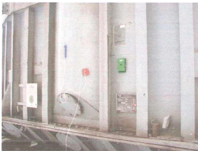
Рисунок В.1 - Установка датчиков МР-У и РИП на карман ввода 500 кВ
