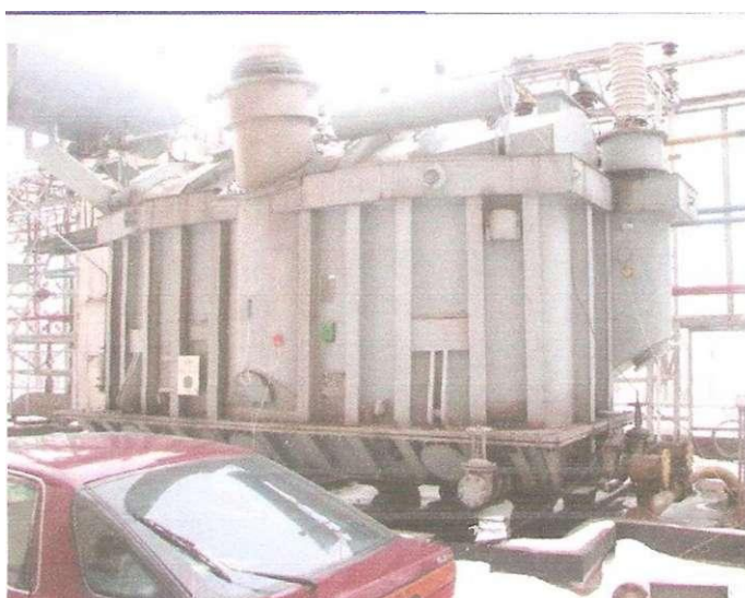
Рисунок В.2 - Установка датчиков на трансформатор
