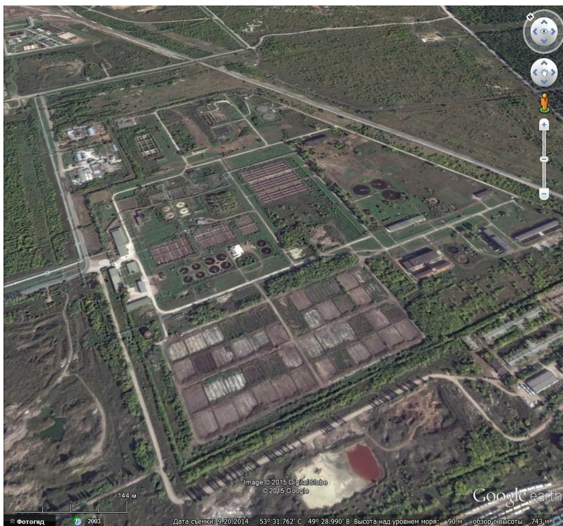
Рисунок 1 – Очистные сооружения ООО «Тольяттикаучук»
