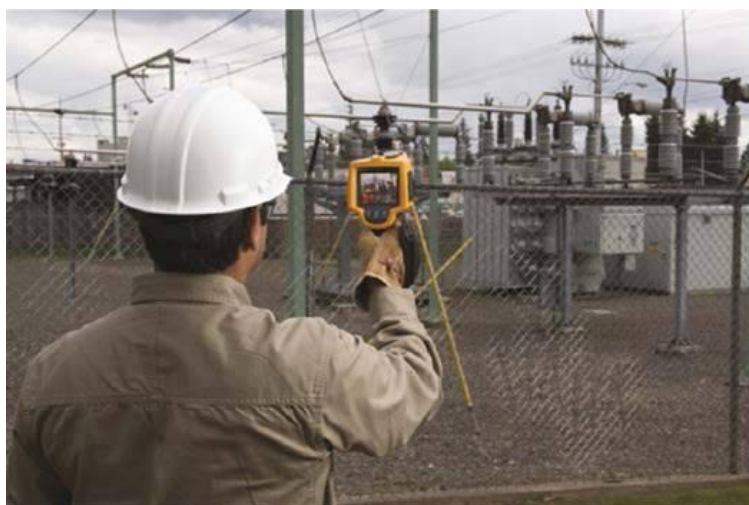
Рисунок 12 – Пример исследования подстанции тепловизором
