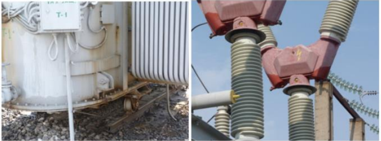
Рисунок 10 - Утечка масляных жидкостей в трансформаторе Т1 (а) И масляного выключателя секционного (б) в трансформаторной подстанции
