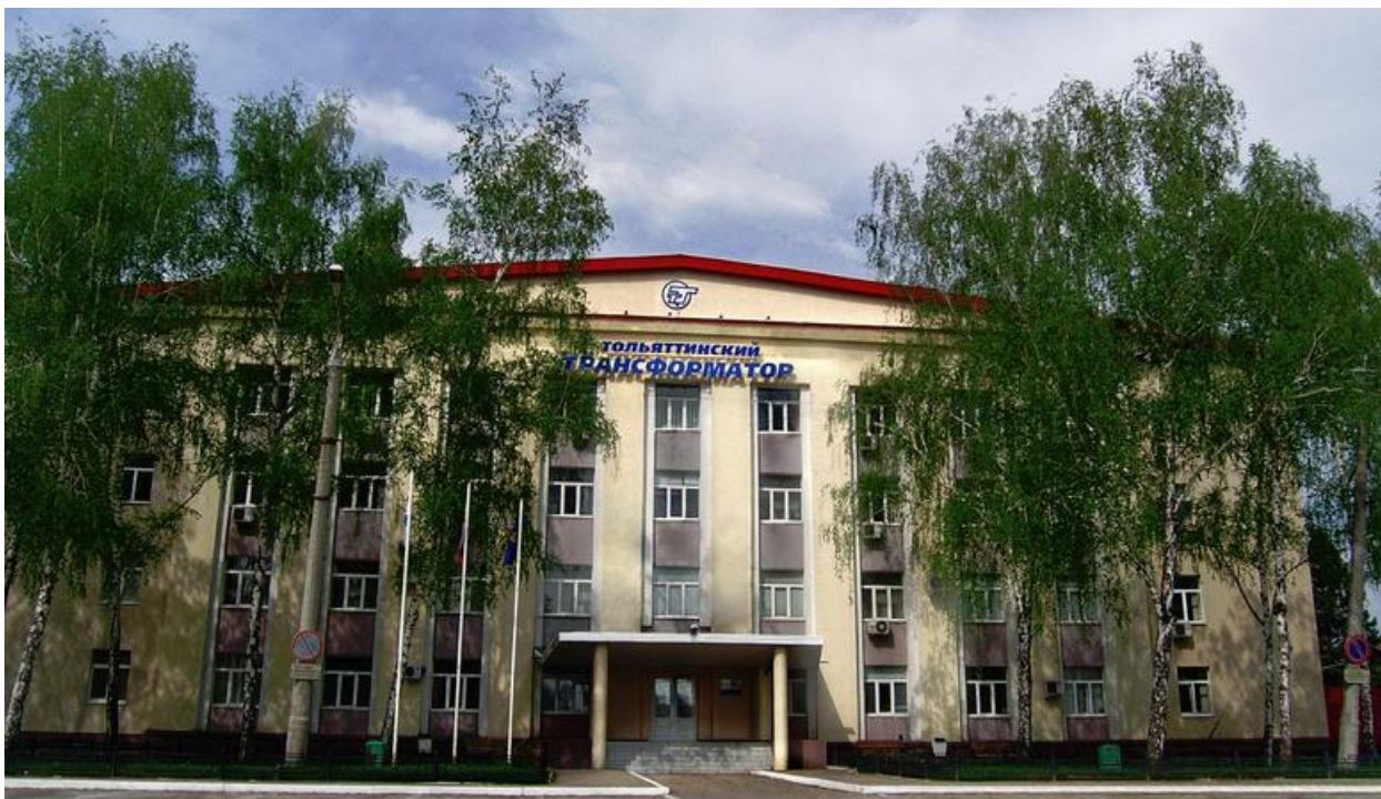
Рисунок 1 – Вид здания ООО «Тольяттинский Трансформатор»
