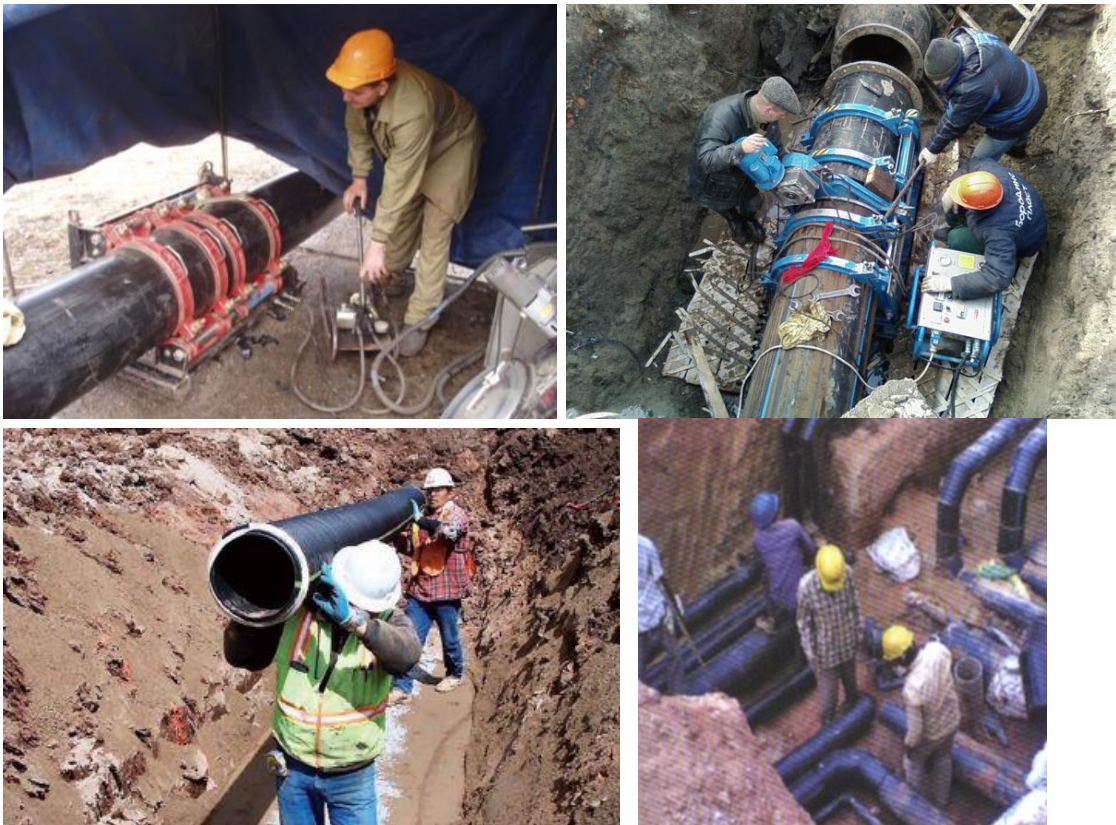
Рисунок 17 – Работа сварочного оборудования на монтаже
