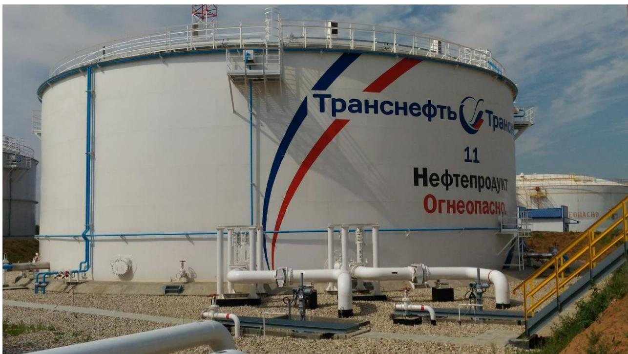
Рисунок 1 - Вертикальный резервуар
