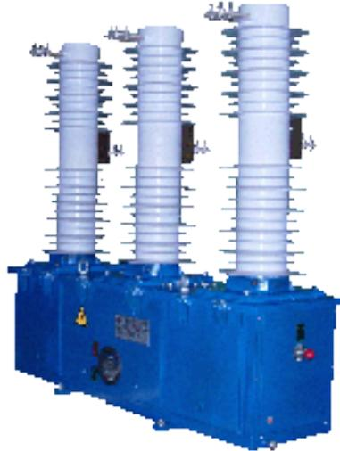
Рисунок 6 - Внешний вид и конструктивные особенности выключателя ВБЭС-35
