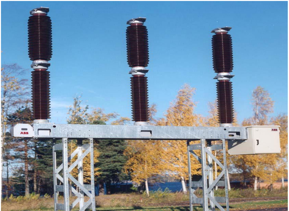
Рисунок 10- Элегазовый выключатель с пружинным приводом типа VLK222c заводкой от электродвигателя.
