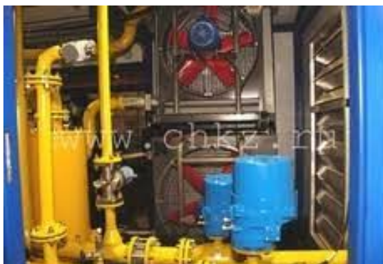
Рисунок 4 – Компрессор АГНКС от производства ООО «ЧКЗ»
