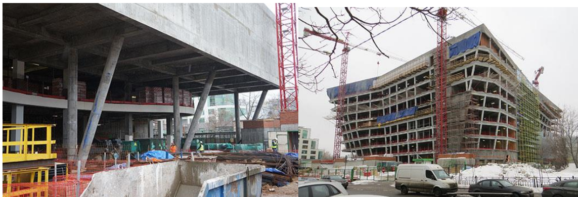
Рисунок 6 – Элементы каркаса офисного здания
