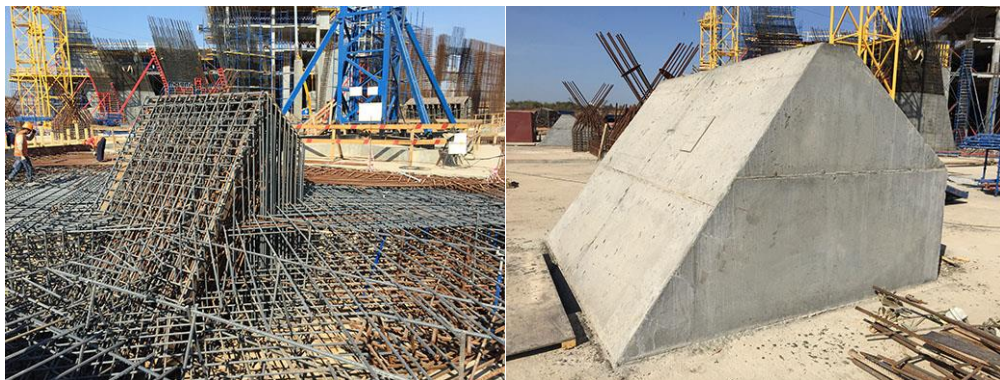
Рисунок 3 – Густоармированная конструкция опоры стадиона «Самара-Арена»
