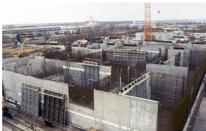
Рисунок 4 – Густоармированные конструкции стен
