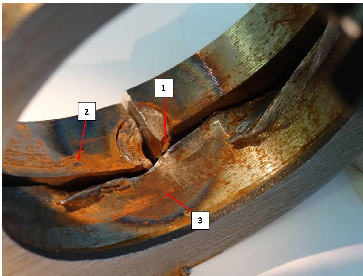
Рисунок 26 – Внешний вид сварного соединения со стороны внутренней поверхности трубы маятниковой опоры
