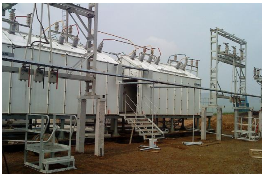
Рисунок 9 – КРУ типа КРУ – СЭЩ – 59
