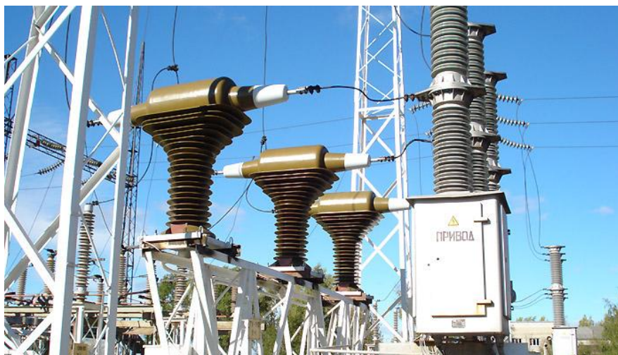
Рисунок 7 – Трансформатор тока ТОЛ-110 УХЛ1
