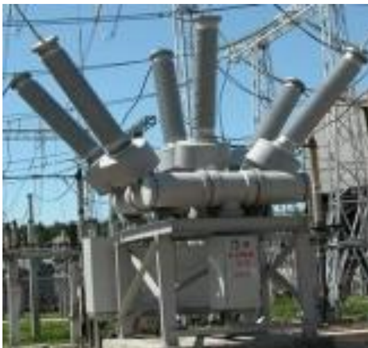
Рисунок 5.1 – Внешний вид выключателя марки ВГБ-110-31,5/400У1
