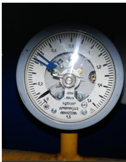
Рисунок 7 — Пример правильно настроенного манометра
