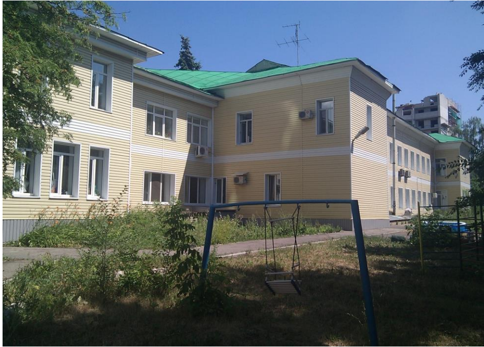
Рисунок 1 – Внешний вид рассматриваемого объекта социальной защиты
