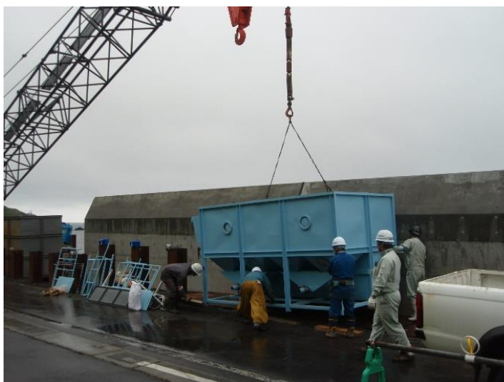
Рисунок 6 – Монтаж оборудования компании NIIHON KASETSU
