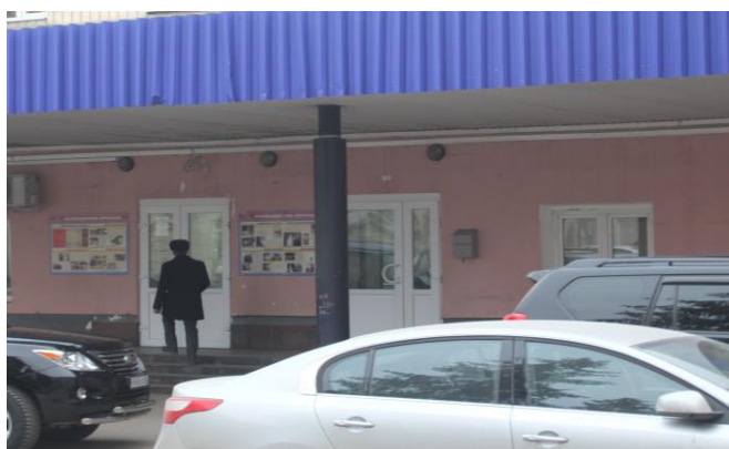
Рисунок 4 – Вид с проходной №2
